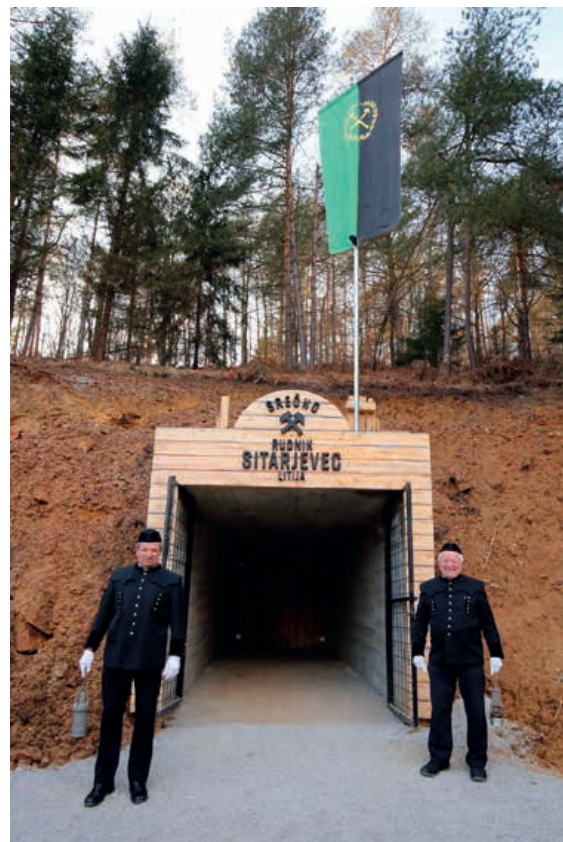
Prenovljeni portal Izvoznega rova (foto: Gregor Požun)
